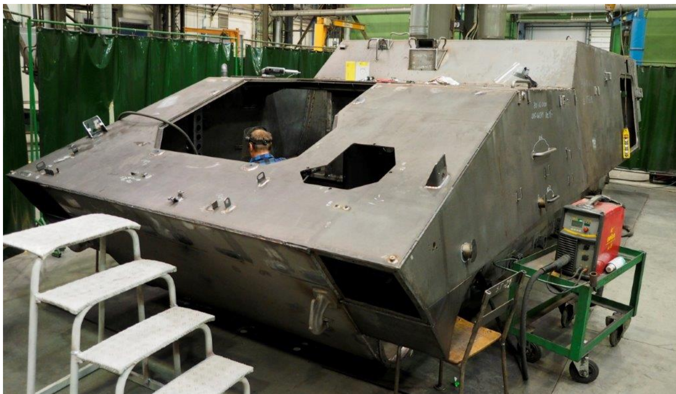
Prace spawalnicze przy wozach dowodzenia i dowódczo-sztabowych dla DMO Regina (WD i WDSz) na razie prowadzone są na dotychczasowych stanowiskach, podobnie jak prace przy wieżach moździerza automatycznego 120 mm Rak. Fot. Jerzy Reszczyński
